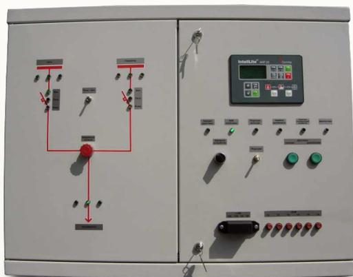
Для систем ввода резерва мы традиционно предлагаем свои встроенные и внешние АВР 1.0, 2.0., соответствующие мощности конкретного дизель-генератора. По желанию заказчика возможно использование АВР сторонних производителей, например, стандартные АВР 2.0, 2.1, 3.0, 3.1 фирмы Moeller.
